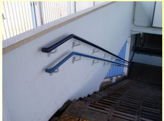
階段手すり設置状況
