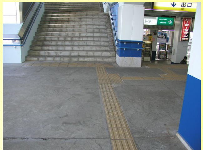
駅構内通路（点字ブロック設置状況）
