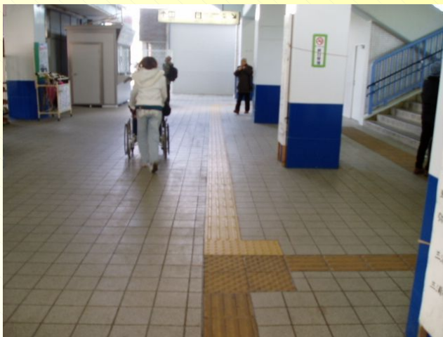
駅構内通路（点字ブロック設置状況）
