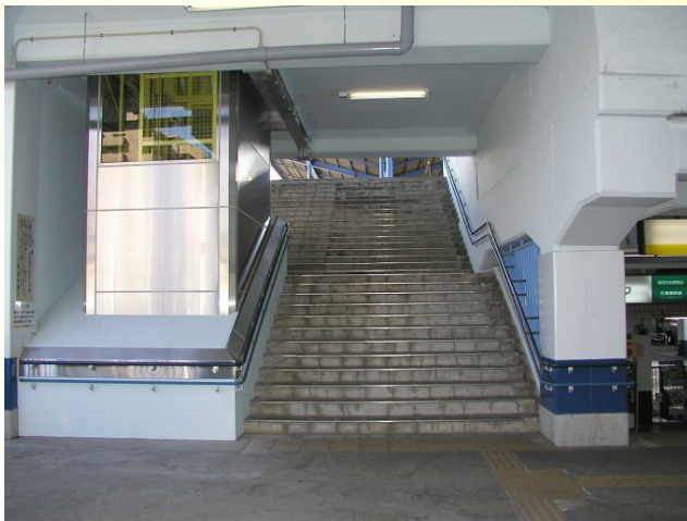
駅構内通路（点字ブロック設置状況）
