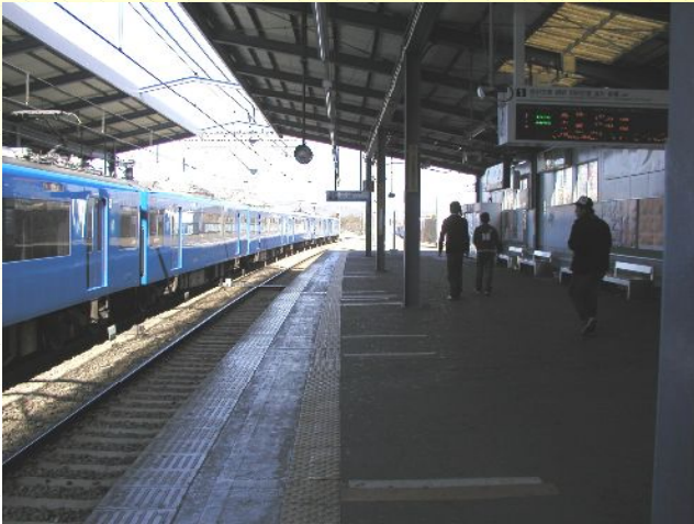
点字ブロック設置状況
