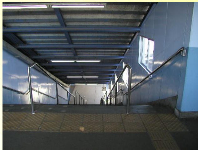
手すり設置状況
