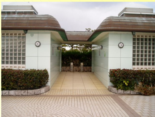
入口ゲート付近トイレ入口
