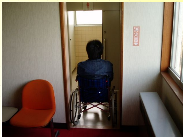
車いす対応トイレ入口
