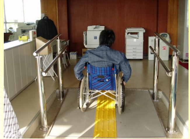
入口スロープ
