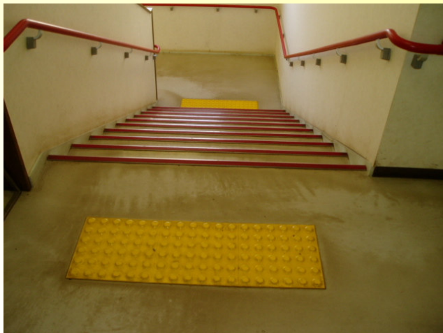
階段（点字ブロック・手すり）
