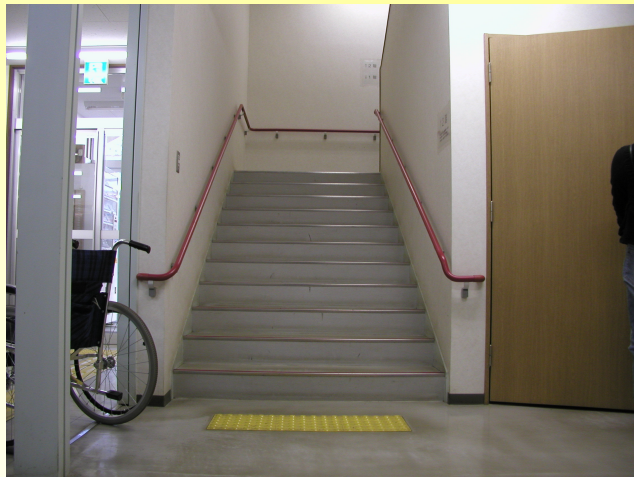
階段（点字ブロック・手すり）
