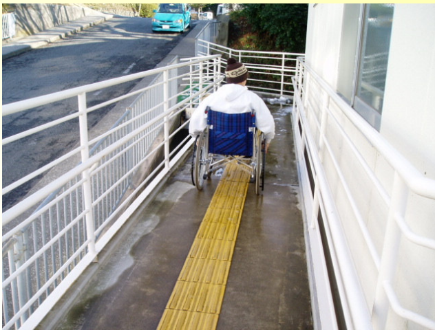
第3駐車場からのスロープ
