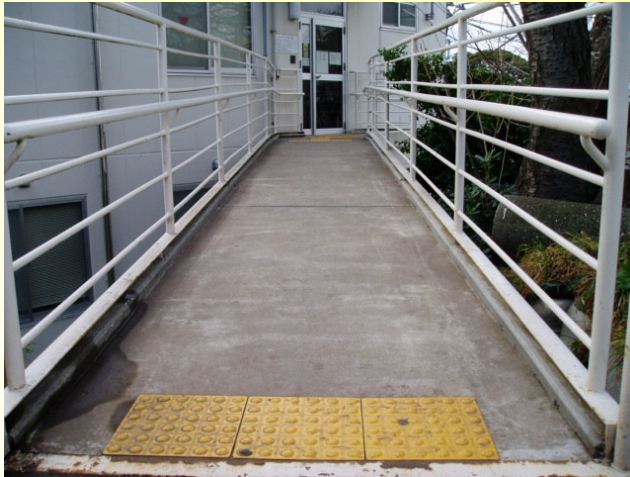
3階入口スロープ
