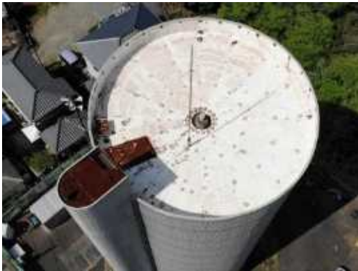
図 2-4 小網代配水塔
