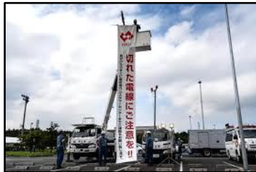
東京電力パワーグリッド
