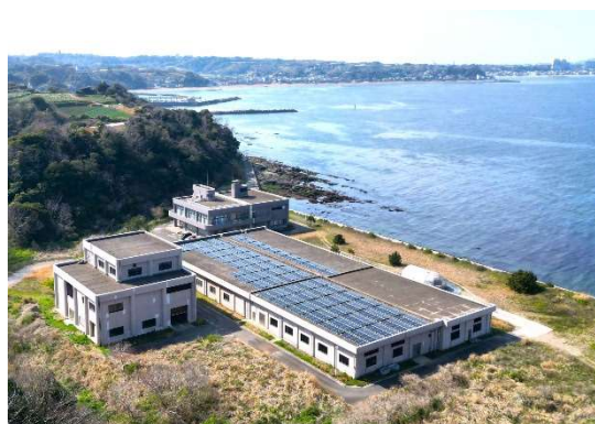
東部浄化センター（遠景）
