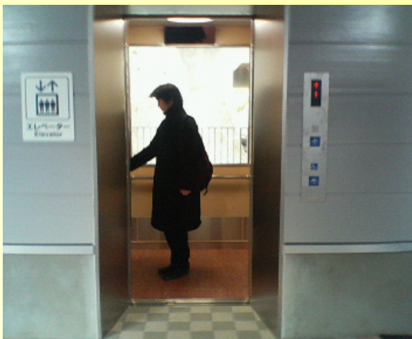
エレベーター出入口
