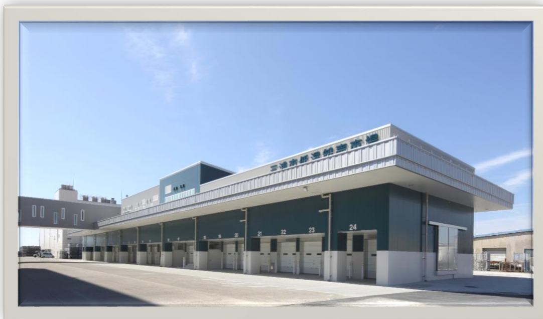
三浦市低温卸売市場 (平成30年3月竣工)
