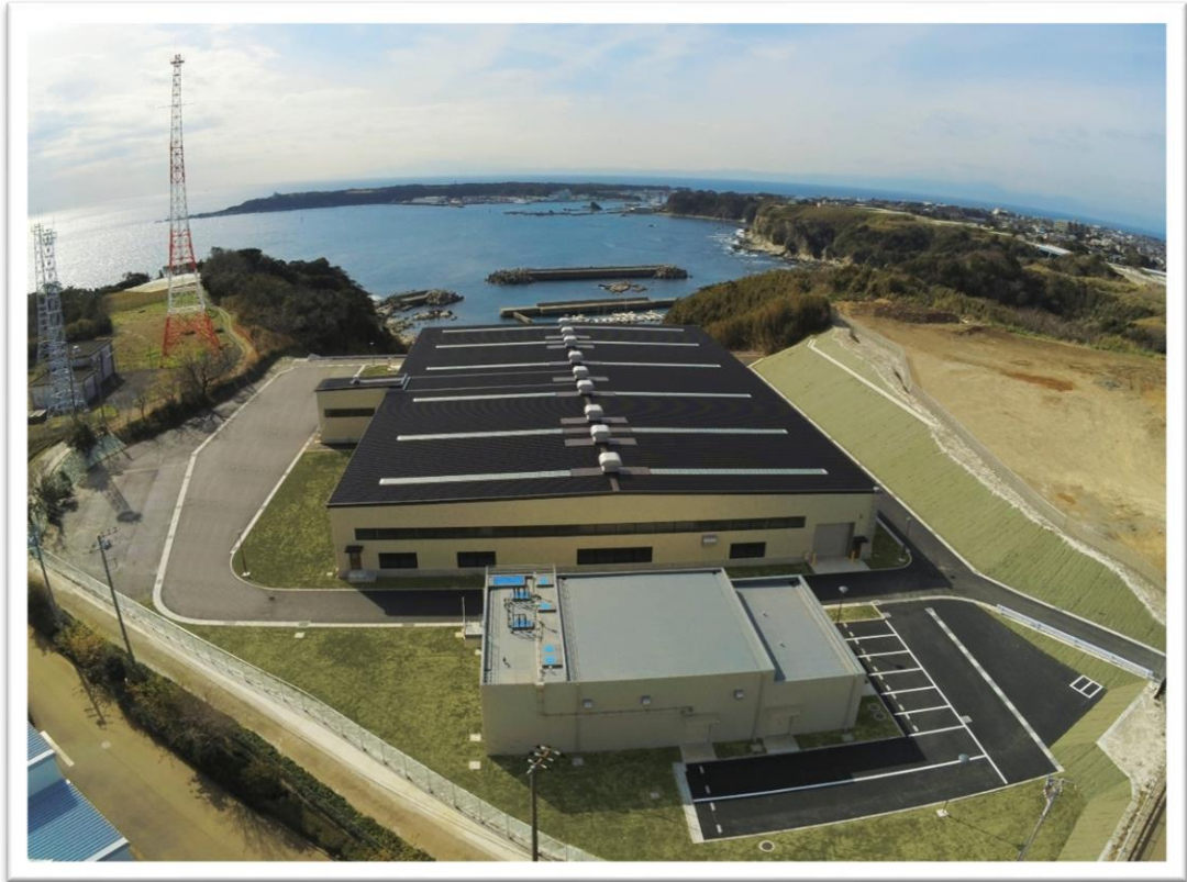
三浦市一般廃棄物最終処分場 (令和2年2月竣工)
